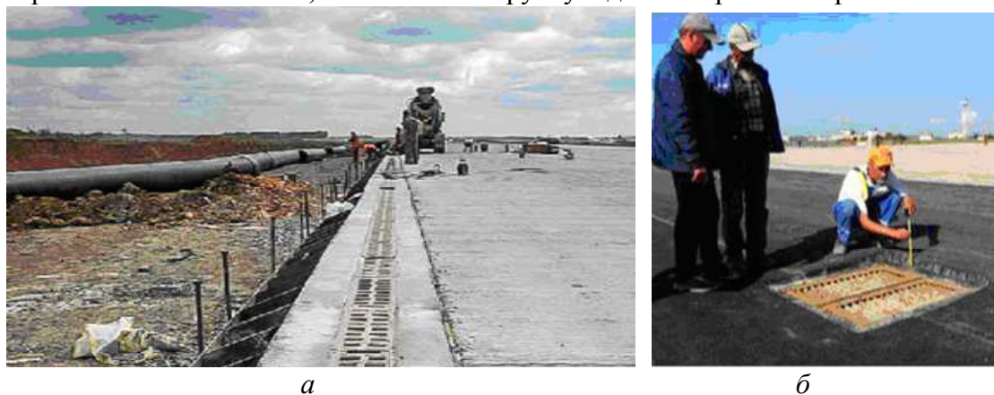
Рис. 8. Прокладання підземних комунікацій:
