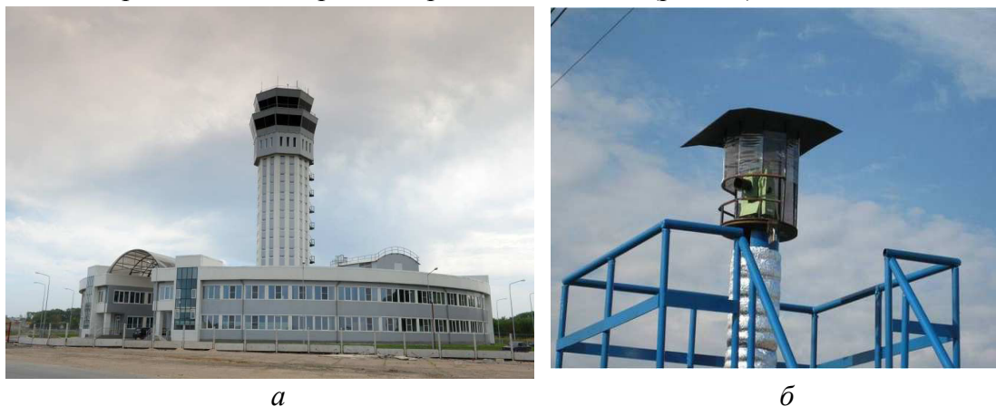
Рис. 10. Спостереження за креном та деформаціями споруд аеропорту: а – КДП аеропорту; б – вежа з електронним тахеометром усередині
