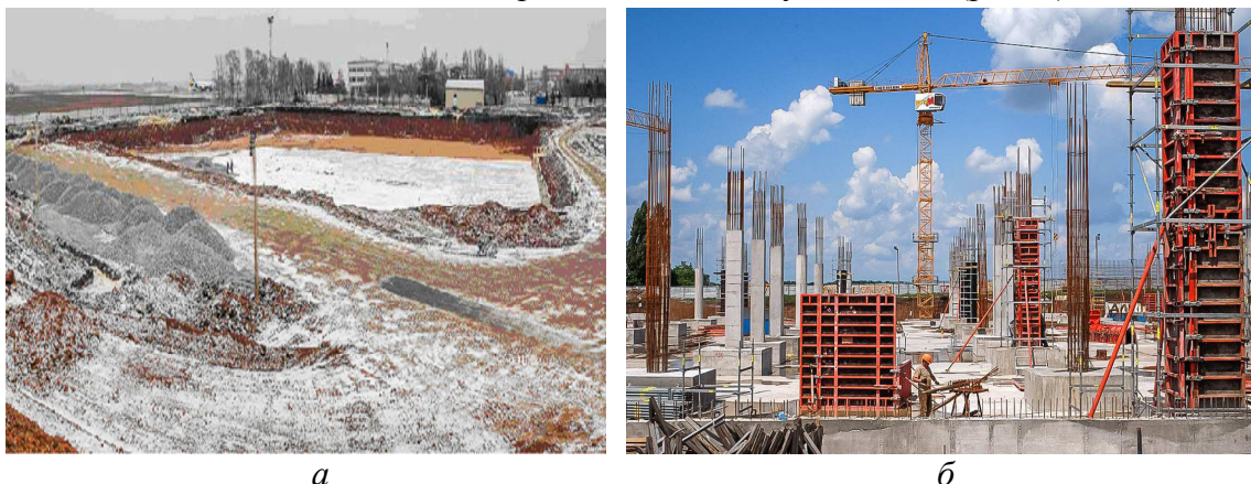
Рис. 7. Етапи будівництва споруд аеродрому:
