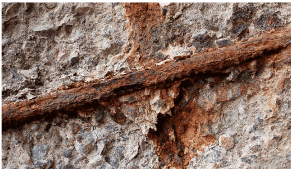
Рис. 3. Схематичне зображення тріщиноутворення в залізобетоні внаслідок корозійних впливів на металеву арматуру:
