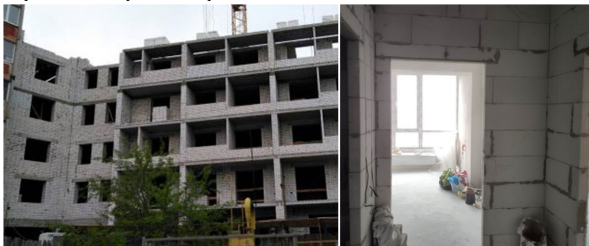
Рис. 2. Житловий комплекс у процесі будівництва [6]
