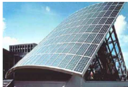
Рис. 10. Спосіб розташування масиву фотопанелей під різними кутами до сонця
