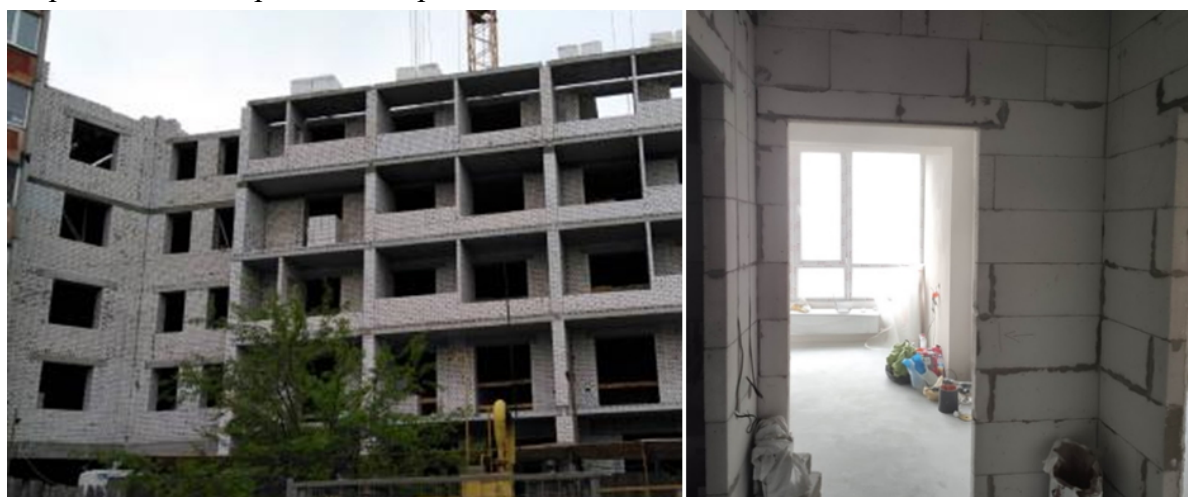
Рис. 2. Житловий комплекс у процесі будівництва [6]
