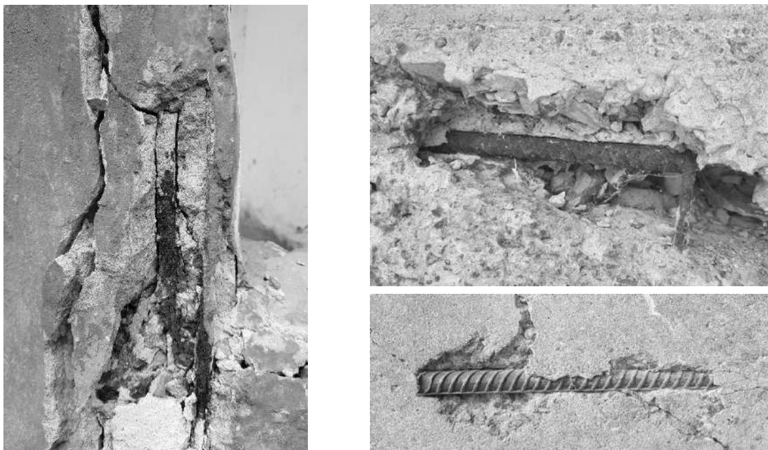
Рис. 1. Наслідки корозійних впливів в елементах ЗБК
