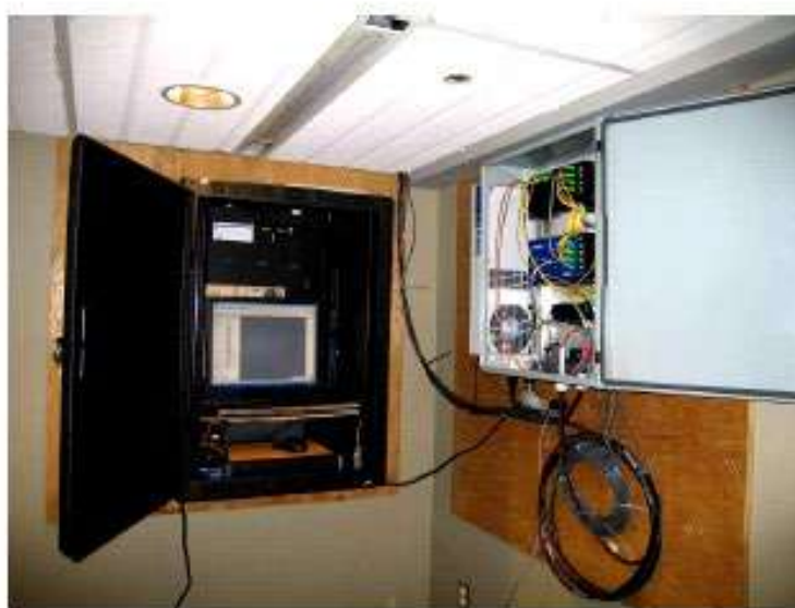
Рис. 6. Елементи системи моніторингу: а) – ROBOVEC встановлений на колоні в центрі станції метро; б) - центральний вимірювальний пункт зі спеціальним комп'ютером (ліворуч) та волоконно-оптичним блоком зчитування [8]
