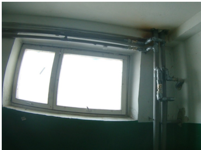
Рис. 1. Фрагмент прокладання подавального та зворотного трубопроводів на сходовій клітці
