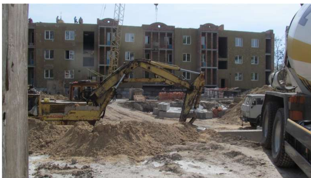
Рис. 3. Будівництво житлового будинку на вул. Князя Чорного 4
